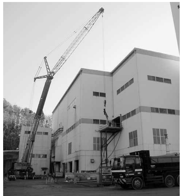
工事の状況（解体物の搬出）
